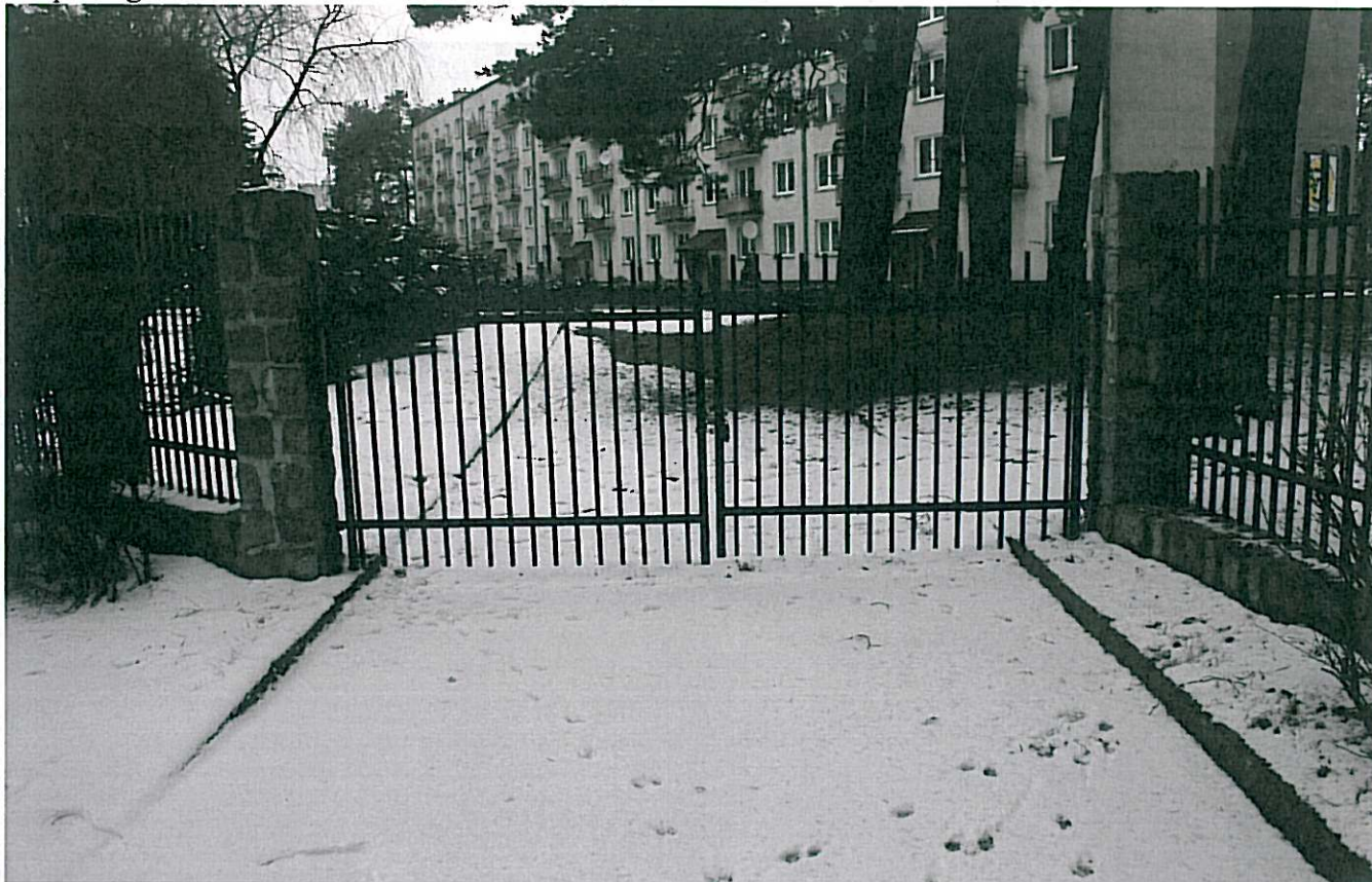
9. Brama wjazdowa na drogę pożarową do budynku B (szerokość bramy 3.10) wjazd od ul. Aleja Niepodległości
