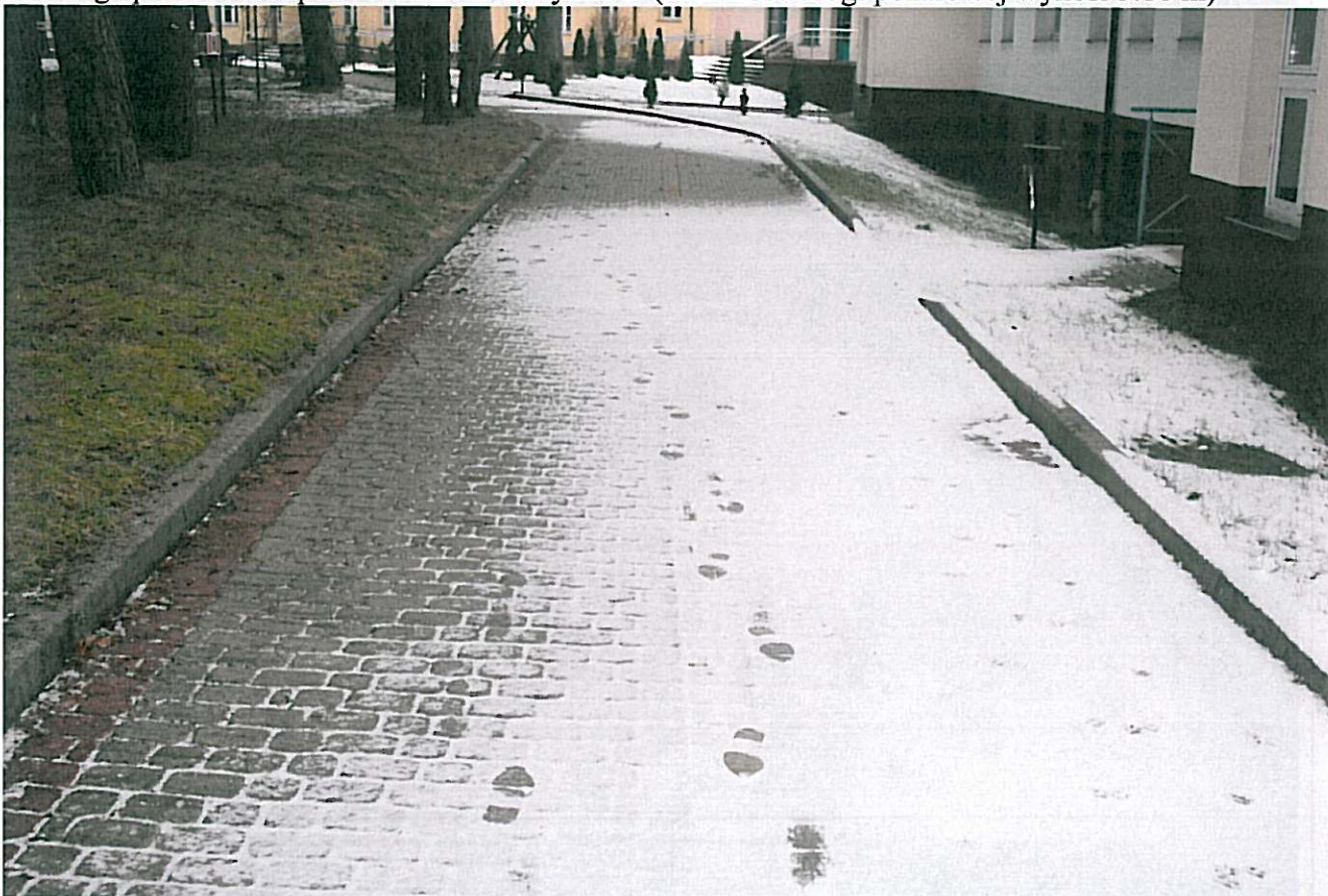
10. Droga pożarowa doprowadzona do budynku B (szerokość drogi pożarowej wynosi 3.10 m)
